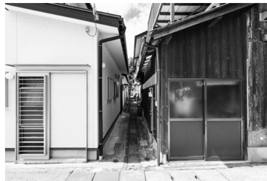
図 23 宅地背割り線上の下水溝と家屋のセットバック ©Tetsuya & Tomoyo Hayashiguchi.
