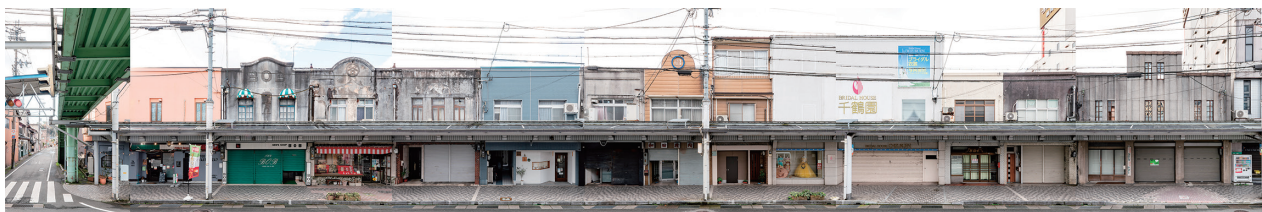
▲北但大震災後に建設された鉄筋コンクリート造長屋。©Tetsuya & Tomoyo Hayashiguchi.
