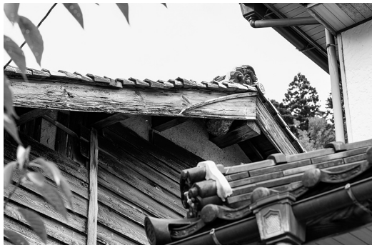
図4 明治期に建てられ大火を免れた家屋 かつて空地だった側の棟・母屋・桁とケラバは 裸のまま残されている。 ©Tetsuya & Tomoyo Hayashiguchi.
