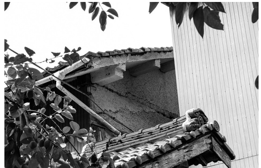
図5 図4と同じ家屋（反対の妻壁） 図4と反対側の妻壁は隣家が迫っていたため、 防災として土が塗り込められている。 ©Tetsuya & Tomoyo Hayashiguchi.
