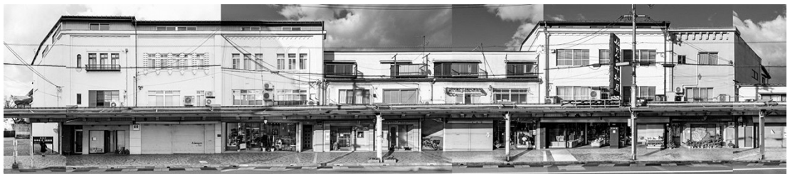
図 16 寺町エリアに並ぶ 3 階建ての民間耐火建築 (共同建築)
