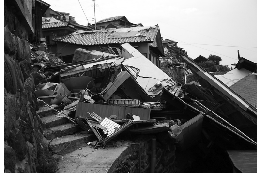
写真1 福岡県西方沖地震で斜面に建つ住宅の7割が壊れた玄界島(2006年6月山中撮影)
