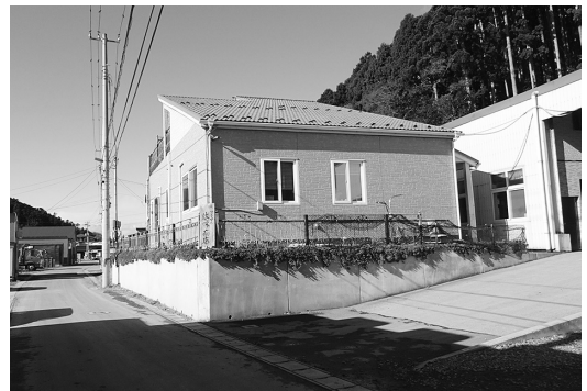
写真8 ワカメ業者の事務所建設
