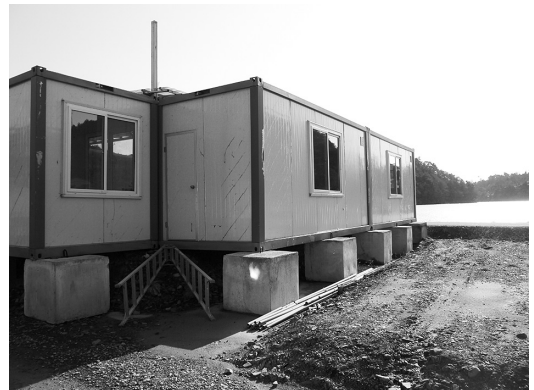
写真7 自力で嵩上げて番屋を建設
