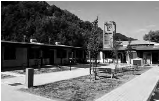
写真38 アルクワータの仮設住宅
