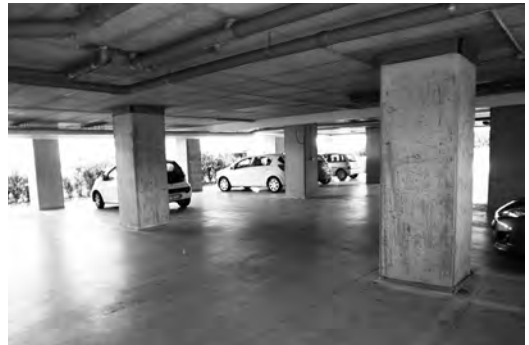
写真15 CASE住宅のピロティ(耐震デッキ)
