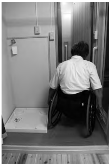
写真6 車いすでは入ることも出来ない仮設住宅の風呂やトイレ
