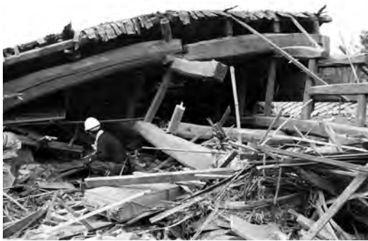
写真8 倒壊した家屋の撤去作業。この跡地に新しい被災地障害者センターくまもの拠点を整備
