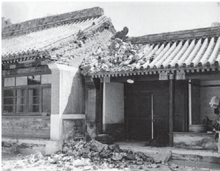
図22, 23 古建築の被害
