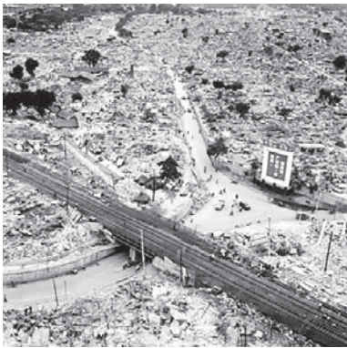
図3 地震により破壊された唐山
