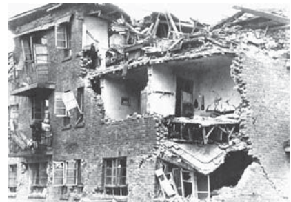
図20 天津の被害状況
