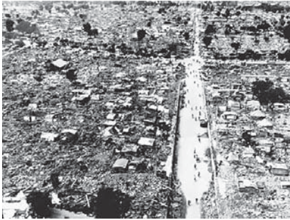
図2 地震により破壊された唐山
