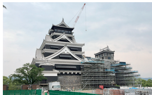
▲修復工事中の熊本城（2020 年頃）
