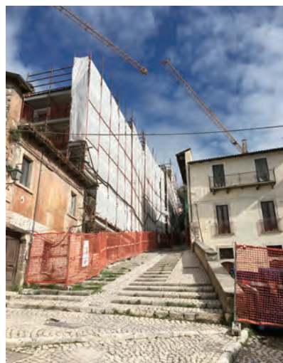
▲ラクイラ市 工事の進む市街地区（2019年5月撮影）
