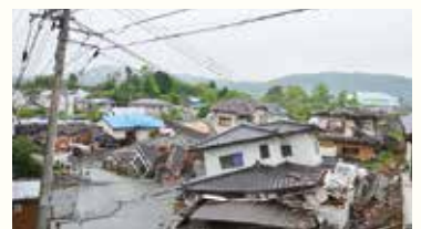
▲熊本地震の被災地調査（熊本県益城町） 2016年4月23日
