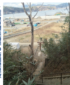
▶釜石市根浜海岸の防潮堤建設
