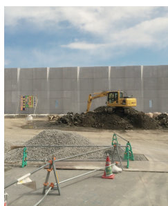
▲宮古市鎌ヶ崎地区の防潮堤工事
