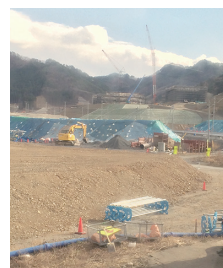
▲釜石市鶴住居地区のかさ上げ工事
