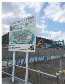
▶大槌町の震災復興工事
