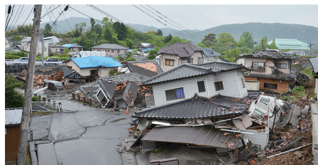
4月23日、熊本県益城町で 川沿いの地盤が崩れ、軒並み倒壊した住宅
