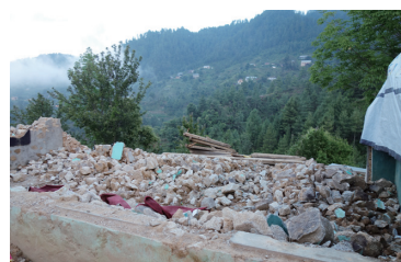
▶崩壊した校舎
