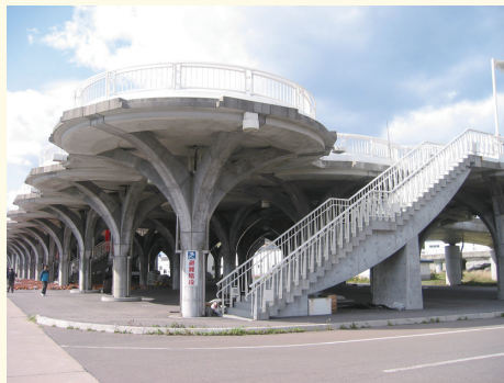
▲奥尻島青苗地区に設置された人工地盤、津波の負荷軽減、避難所等への連絡路として機能
