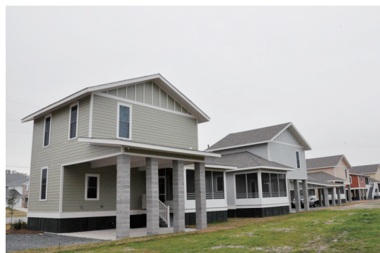
Project Home Again による新築住宅の建設工事。おぼろげに「全米」の入り組んだ状況を示している。
