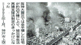
阪神大震災では全半壊した住宅が約25万棟に上り、被災者生活再建支援法制定のきっかけになった。1995年1月、神戸市上空
