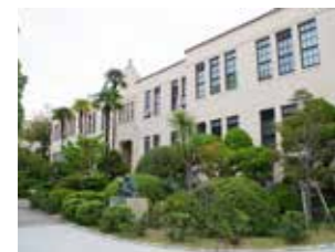
■高中部本部棟 1933年、関西学院の上ヶ原移転に際して建てられた、ヴォーリス建築の名作です。
