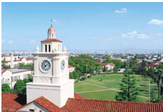
大学図書館屋上より
