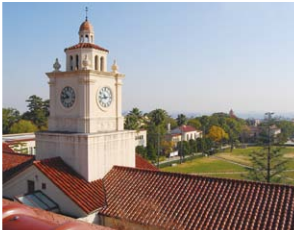
大学図書館屋上より
