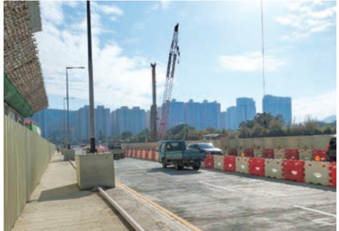
新興住宅が立ち並ぶタイパ島石排湾地区に接続する新交通システムを建設中
